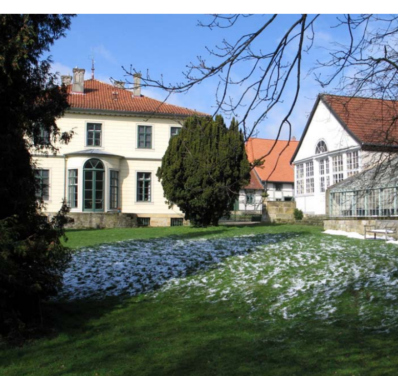
Gartenfassade des Wohnhauses mit Glashaus (Foto: Struck).
