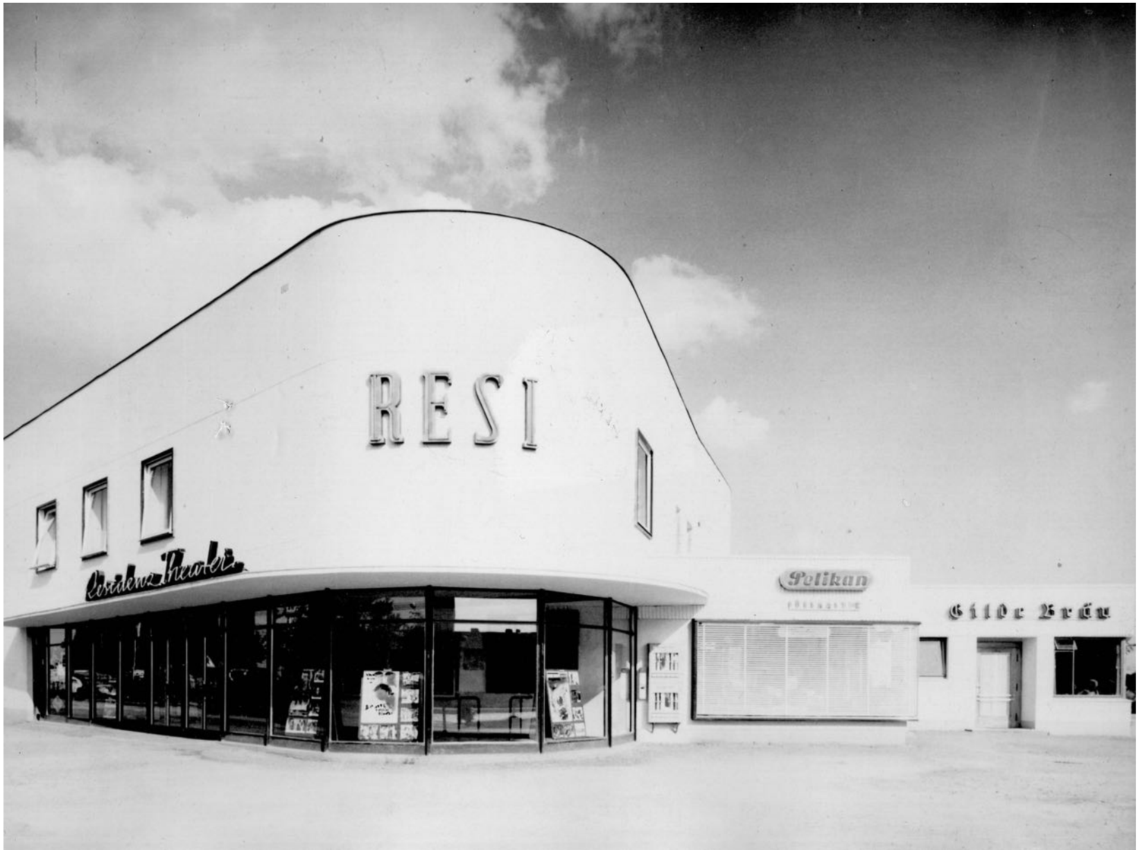
Residenz-Theater, Fassadenansicht, o. J.
