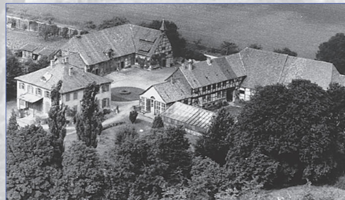
■ Luftbild des Herrenhauses und der Wirtschaftsgebäude
